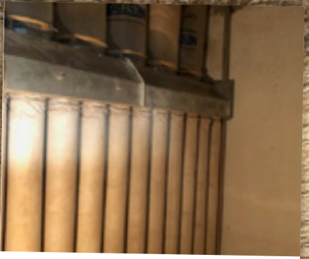
ABSauganlage Nestro Baujahr: 1995 Art.-Nr.: AE-P-21008
