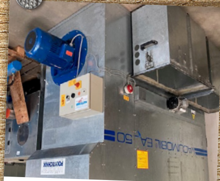
ABSauganlage Höcker Polytechnik EA 250-5 A Baujahr: 1997 Art.-Nr.: AE-P-21018
